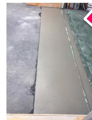
フォークリフト走る土間をアスファルトで補修したが下がってしまい、養生期間が短く下がらないものを探して1day採用。
